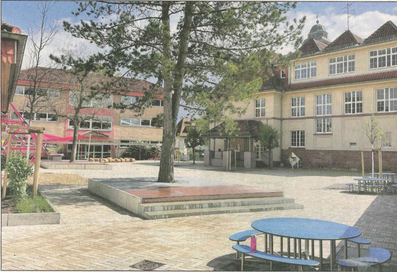
Der neu sanierte Schulhof: helle Pflastersteine und viele Sitzgelegenheiten
